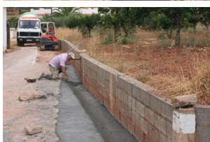
Barrosas – Reparação de pavimento e valeta.
