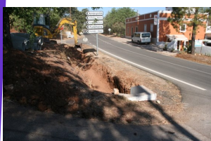
Beirada - Colocação de manilhas e fecho de vala.
