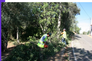
Corte de árvores e arbustos existentes nas bermas da rede viária;
