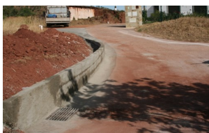
Vale Mendes – Drenagem das águas pluviais e valeta.
