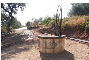
Corte Neto - Pavimentação Rua da Fonte Nova.
