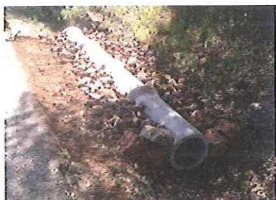
Colocação de manilhas nas travessias para as propriedades
