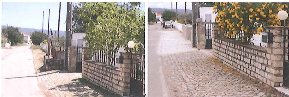
Alargamento de rua com a demolição e reconstrução do muro
